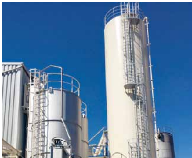
Kapazitäten erweitert: Addcon hat die Produktionskapazitäten für seine Futter- und Nahrungsmittel-Zusatzstoffe in Bitterfeld und Porsgrunn in 2017 deutlich erhöhen können.
