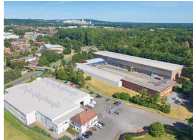
Lagerflächen, Buchhaltung, Einkauf und Geschäftsführung: Mit dem Kauf der Nachbarimmobilie (rechts im Bild) wurden alle Bereiche wieder an einem Standort vereint und die Produktionsfläche wurde um das 3-fache vergrößert.
